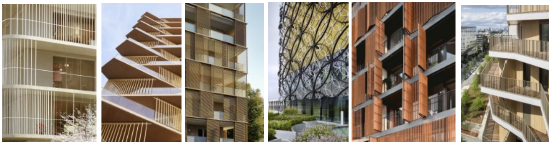
Sfeerbeelden architectuur gevels
